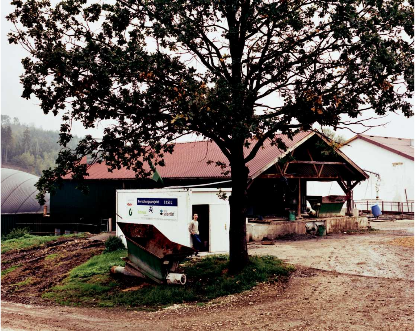
Hier wird am Fortschritt gearbeitet: In dem Container wird Algen Biogas schmackhaft gemacht.
